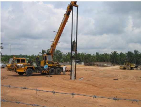
Kerja-kerja menanam cerucuk konkrit untuk antenna penerima
