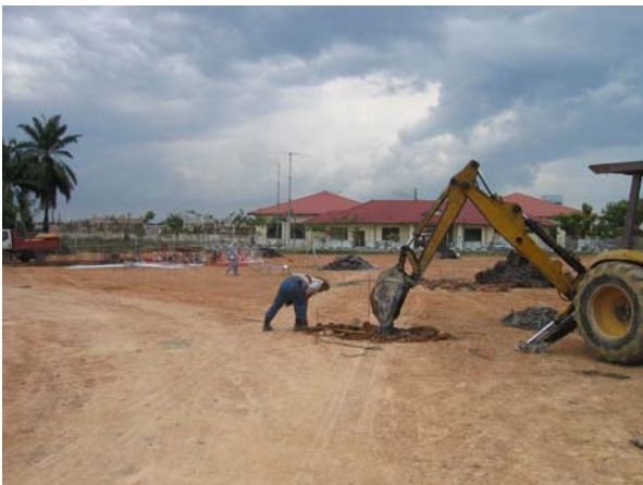
Kerja-kerja pengorekan dilakukan untuk pemasangan antenna penerima
