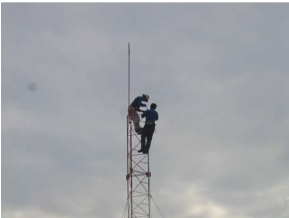
Kerja-kerja pemasangan kotak perintang 600 \Omega
